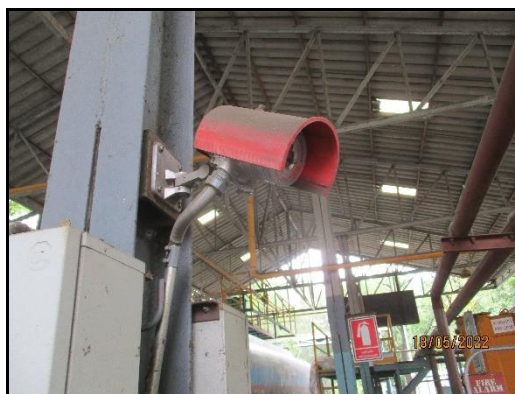
ภาพที่ 2.62 Sensor จับความร้อนบริเวณถังเก็บของเสียที่เป็นของเหลว
