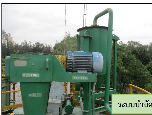
ภาพที่ 2.13 ถังเก็บของเสียที่เป็นของเหลวและระบบบำบัดไอสารอินทรีย์
