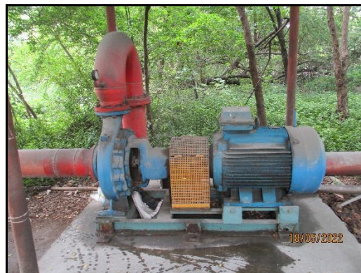
ภาพที่ 2.71 เครื่องสูบน้ำดับเพลิง บริเวณบดซีเมนต์เขาวง
