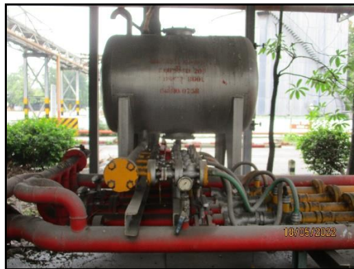
ภาพที่ 2.64 ถังเก็บโฟมบริเวณถังกักเก็บของเสียที่เป็นของเหลว
