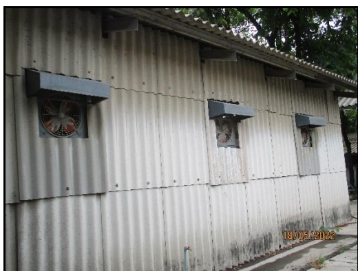
ภาพที่ 2.45 ระบบระบายอากาศเฉพาะที่
