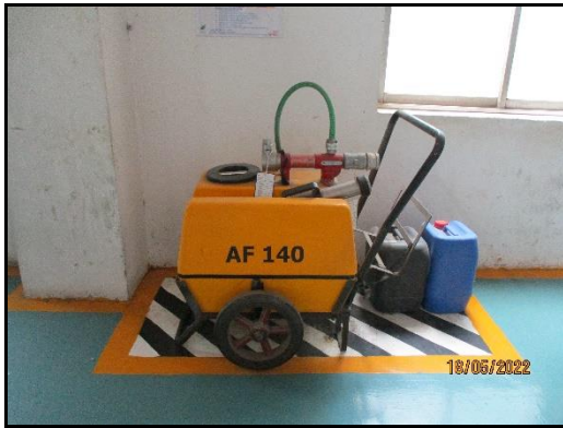
ภาพที่ 2.66 ระบบดับเพลิงด้วยโฟม แบบเคลื่อนย้าย
