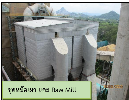
ภาพที่ 2.3 เครื่องดักฝุ่นแบบถุงกรอง (Bag Filter)
