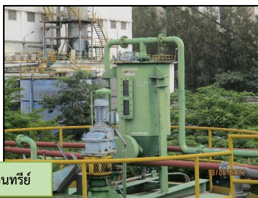
ภาพที่ 2.13 ถังเก็บของเสียที่เป็นของเหลวและระบบบำบัดไอสารอินทรีย์
