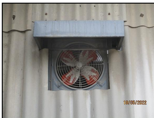
ภาพที่ 2.45 ระบบระบายอากาศเฉพาะที่
