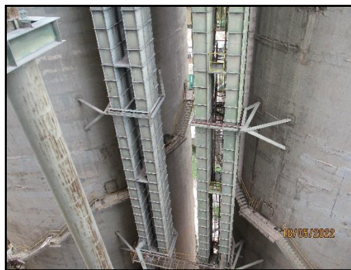
ภาพที่ 2.10 Standby Bucket Elevator
