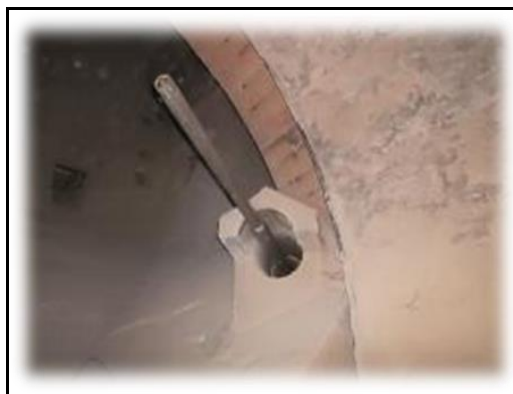
ภาพที่ 2.11 การติดตั้ง Kiln inlet gas analyzer
