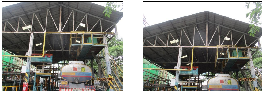
ภาพที่ 2.25 หลังคาป้องกันน้ำฝนบริเวณชุดดูดของเสียที่เป็นของเหลว
