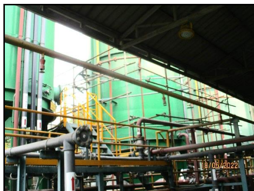
ภาพที่ 2.63 หัวฉีด และระบบหัวกระจายน้ำ-โฟม บริเวณถังเก็บของเสียที่เป็นของเหลว
