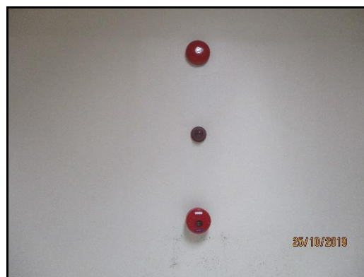
ภาพที่ 2.80 สัญญาณเตือนภัย และเครื่องตรวจจับควัน (Smoke Detector) บริเวณอาคาร CCR
