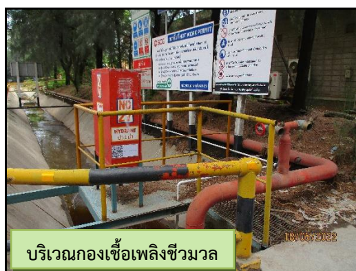
ภาพที่ 2.79 ท่อรับน้ำและสายจ่ายน้ำดับเพลิงภายในโครงการ
