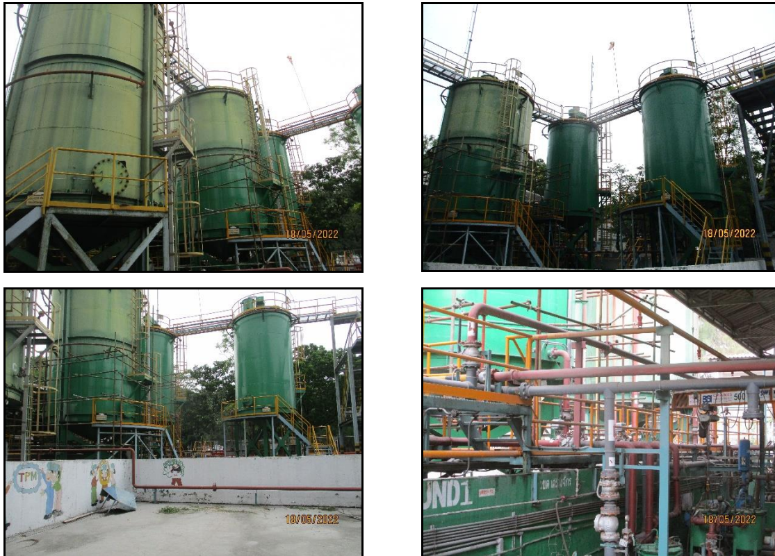
ภาพที่ 2.58 สภาพบริเวณถังกักเก็บของเสียที่เป็นของเหลวและ Bund Wall รอบถังกักเก็บ
