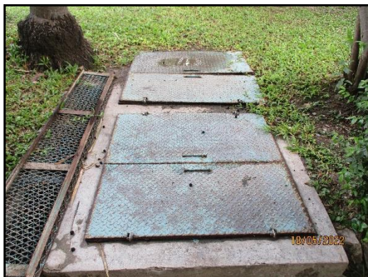
ภาพที่ 2.21 บ่อเกรอะ-บ่อซึม สำหรับบำบัด น้ำทิ้งจากสำนักงาน
