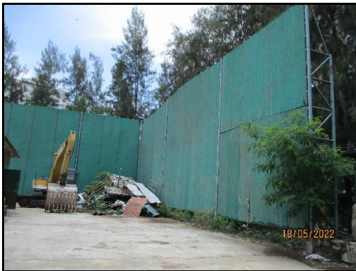
ภาพที่ 2.77 ระบบป้องกันฝุ่นเชื้อเพลิงชีวมวล
