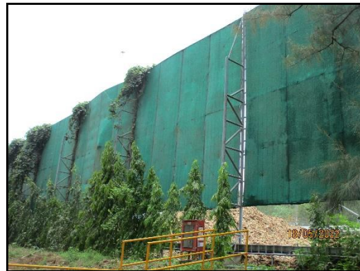
ภาพที่ 2.77 ระบบป้องกันฝุ่นเชื้อเพลิงชีวมวล
