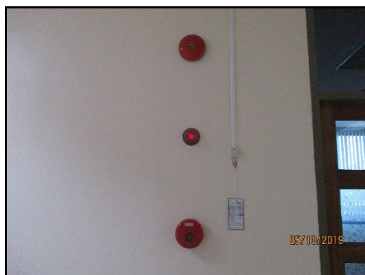
ภาพที่ 2.80 สัญญาณเตือนภัย และเครื่องตรวจจับควัน (Smoke Detector) บริเวณอาคาร CCR
