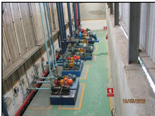
ภาพที่ 2.70 เครื่องสูบน้ำดับเพลิง บริเวณประปา
