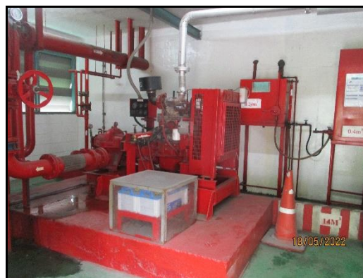
ภาพที่ 2.69 เครื่องสูบน้ำดับเพลิง บริเวณโรงผลิตตุ๊กกระดาศ
